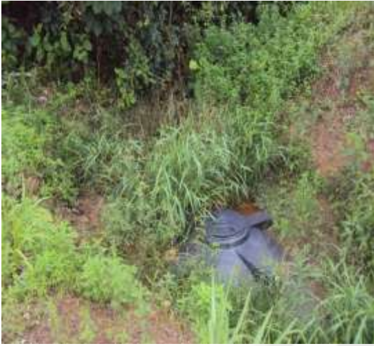
Tratamiento de lixiviados
