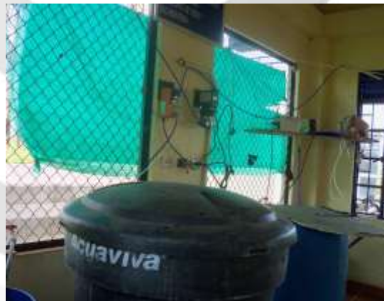
Tanques para preparar las dosificaciones químicas
