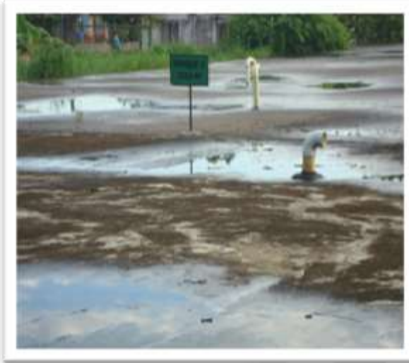
Tanque de almacenamiento y distribución.
