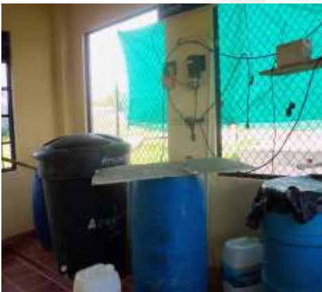
Tanques para preparar las dosificaciones químicas
